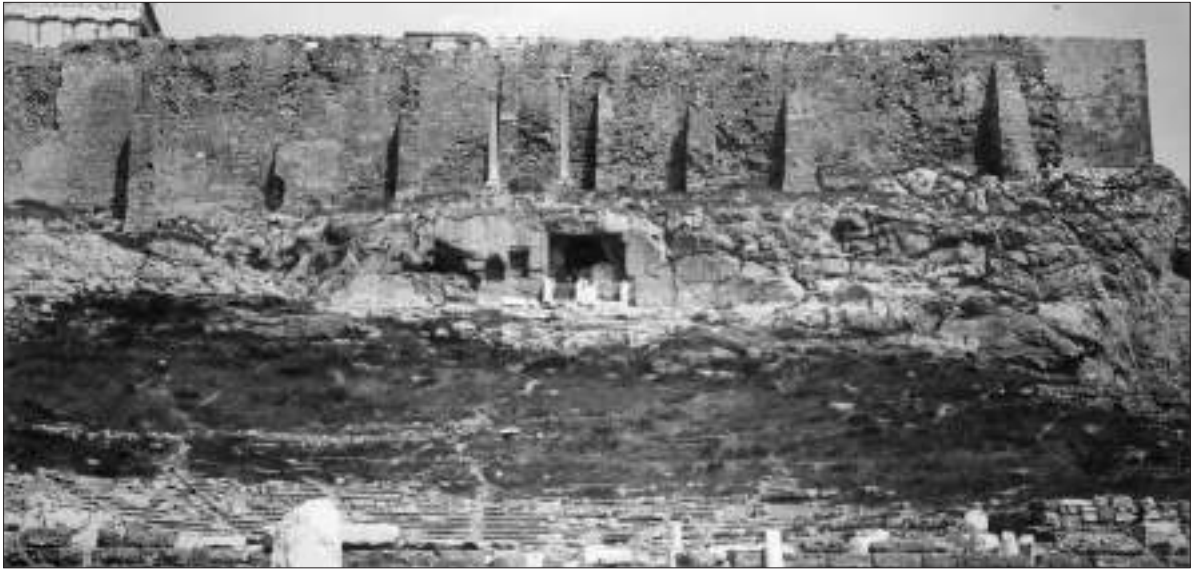
Fig. 28 - Acropoli, mura meridionali, al di sopra del Teatro di Dioniso. Fotografia del 1910 precedente gli ultimi restauri. Si notino tratti del paramento originario di età classica (foto archivio S.A.I.A. neg. A/136)
