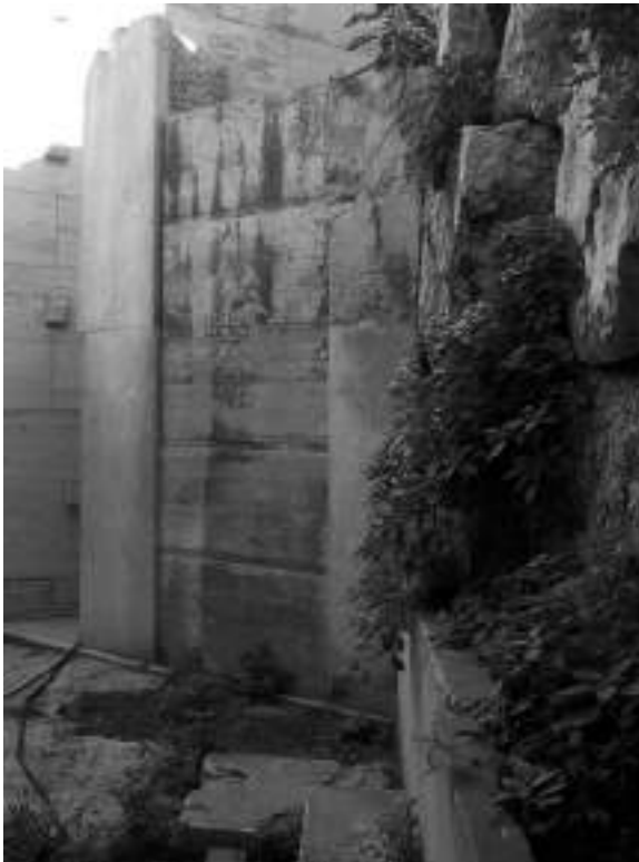
Fig. 55 - Parastas del Vecchio Propylon come restaurata nel 1847-1848. A destra, particolare dei conci
