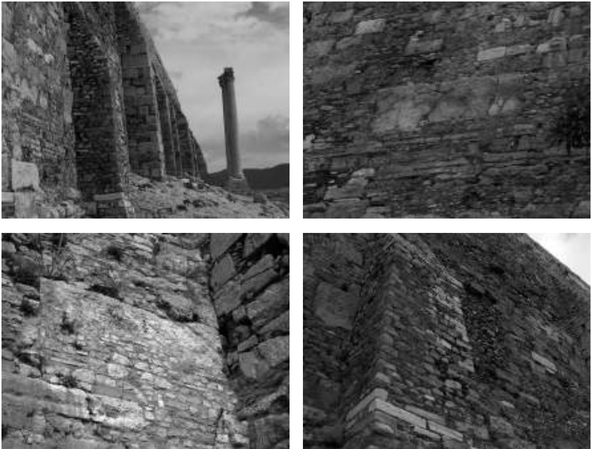
Fig. 33 - Acropoli, mura meridionali, particolari degli architravi arcaici reimpiegati. Si noti l'attuale eterogenea composizione dell'opera muraria
