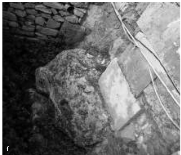
Fig. 18 - Acropoli, mura settentrionali. Materiali arcaici in reimpiego nella cortina muraria. I capitelli e i rocchi in poros del Tempio di Atena (b), rubefatti dall'incendio persiano, gli stessi visibili all'esterno (a). Altri materiali arcaici visibili in c-f
