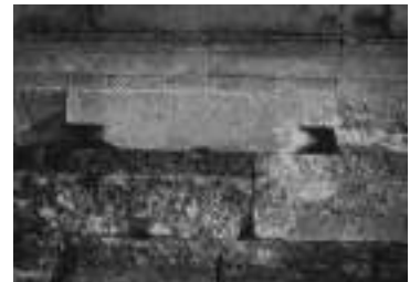
Fig. 135 - Hephaisteion : capitello non finito (da cantiere interrotto dal sacco persiano?) ritagliato e reimpiegato nelle fondazioni (da DINSMOOR 1941)
