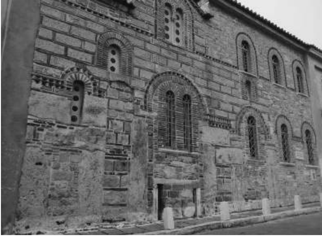
Fig. 80 - Facciata della chiesa di Ag. Nikolaos Rangavas con elementi architettonici antichi di reimpiego
