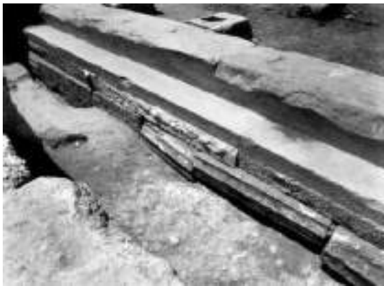
Fig. 101 - La Stoa Basileios : fusti di colonne doriche reimpiegati nelle fondazioni della crepidine, forse nella fase post-persiana (da Agora Guide 1990)
