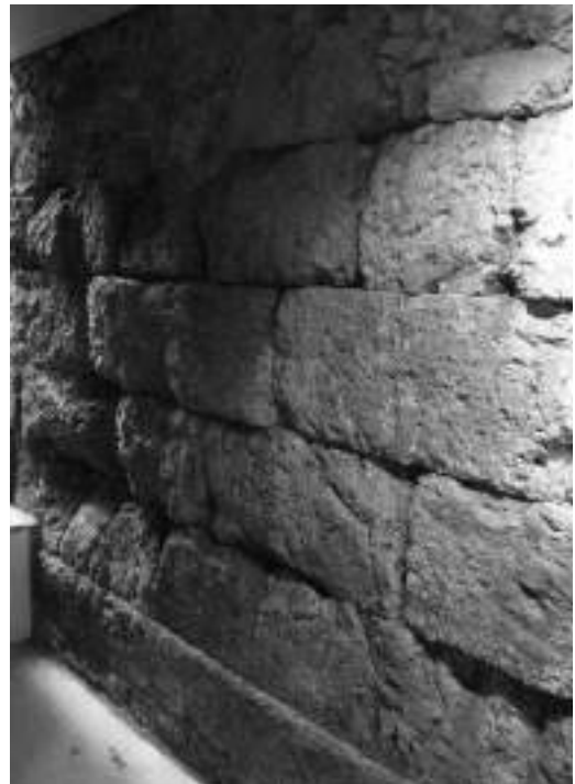
Fig. 82 - Muro di sostruzione di età classica nell'edificio dell'Elliniki Eteria, od. Tripodon 28
