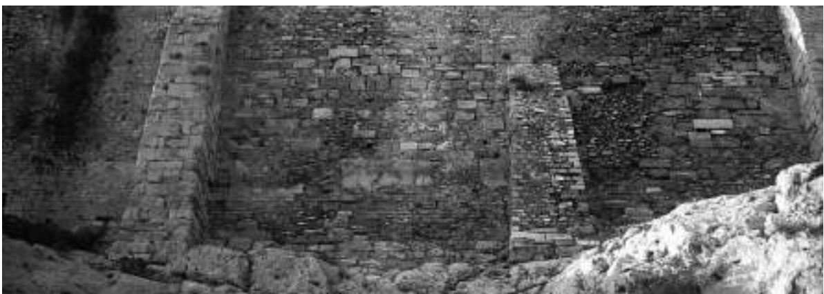
Fig. 31 - Acropoli, mura meridionali, tratto al di sopra del Teatro di Dioniso. Particolare della muratura con gli architravi arcaici (dall' Urparthenon ) in reimpiego
