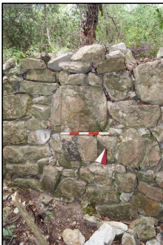
Fig. 14. Monte Pitti: tratto di muro localizzato a sud-ovest della sommità: in evidenza le cesure che rappresenterebbero segno tangibile di una strategia costruttiva che prevedeva la divisione del lavoro in porzioni di lunghezza variabile.
