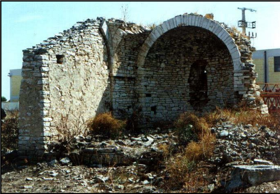
Figura 3. Bitonto, S. Aneta, interno dell'edificio di culto.
