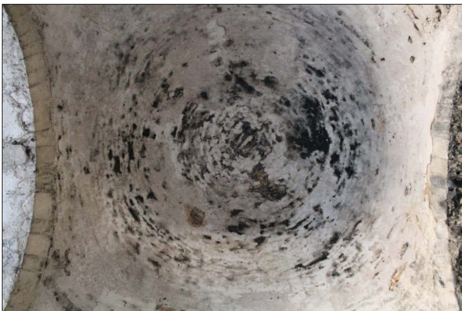
Figura 5. Giovinazzo, S. Basilio, particolare della cupola.
