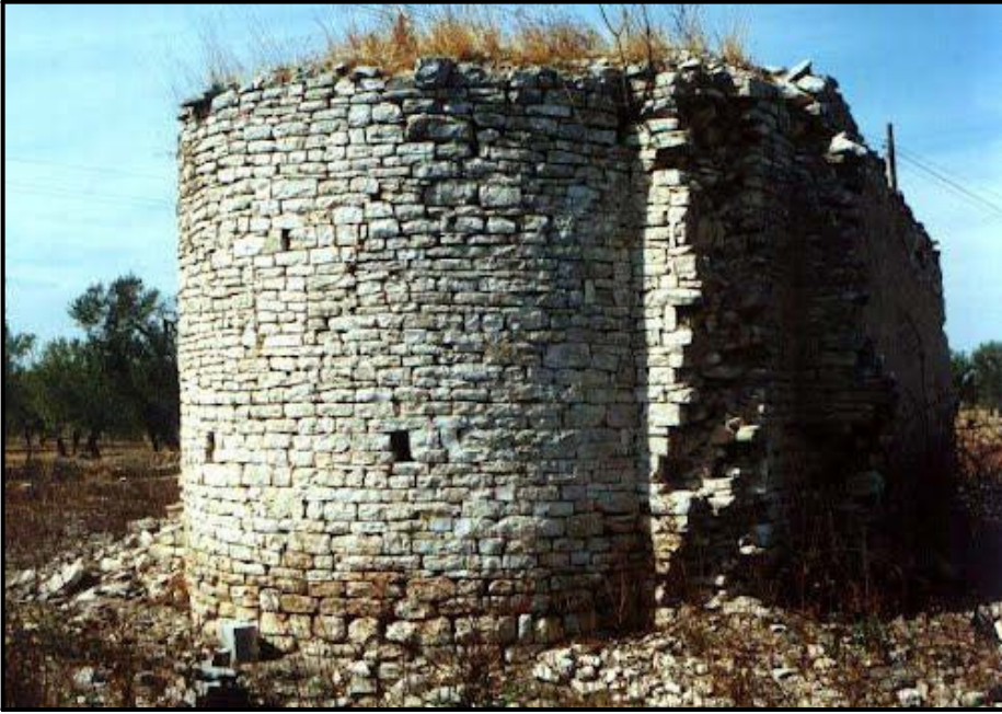
Figura 2. Bitonto, S. Aneta, edificio di culto e particolare dell'abside.
