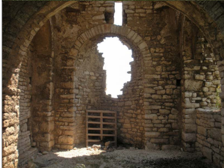
Figura 4 a-b. Rutigliano. S. Apollinare. Particolare dell'abside e interno dell'edificio di culto.
