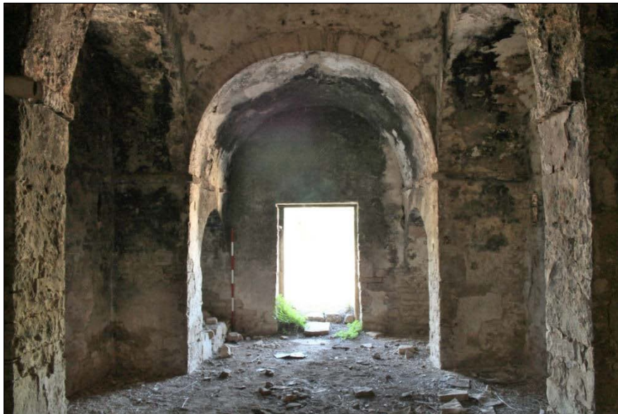
Figura 4. Giovinazzo, S. Basilio, interno dell'edificio di culto.
