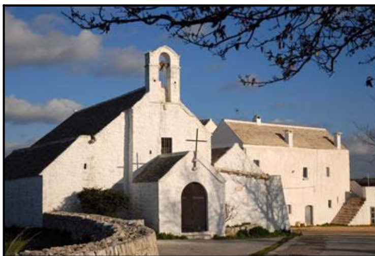
Figura 2. Noci, Santa Maria di Barsento, edificio di culto.
