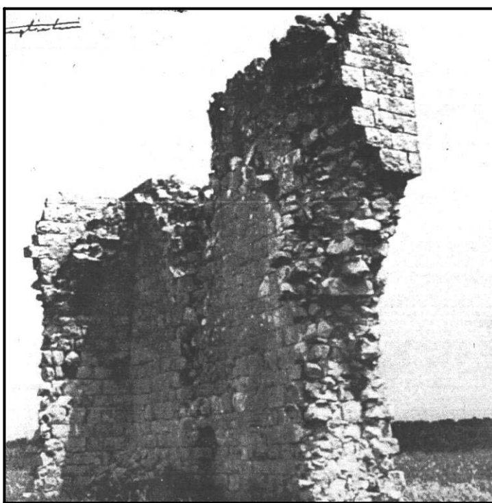
Figura 2. Conversano, S. Nicola Genna, strutture murarie relativa ai resti della torre. (Licinio 1985, fig. 2).
