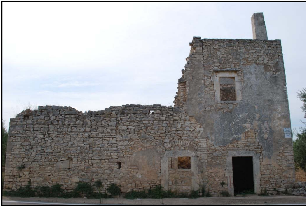
Figura 2. Terlizzi, Forlazzo. Torre e strutture annesse realizzate nel periodo bassomedievale.
