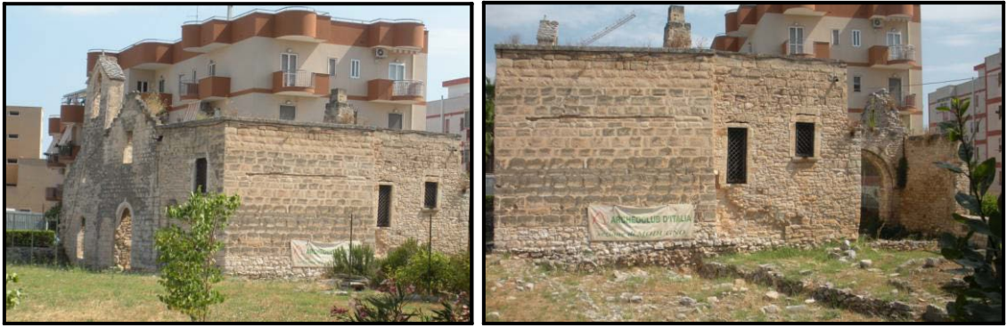
Figure 2-3. Modugno, Santa Maria in Contrada Paradiso, edificio di culto.
