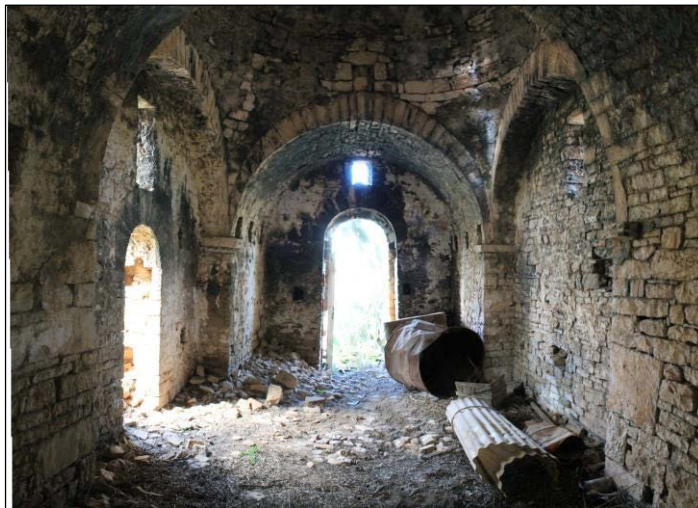
Figura 6. Bitonto, S. Croce, interno dell'edificio di culto.
