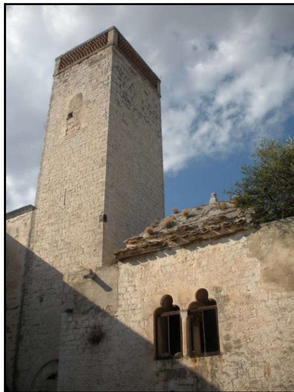
Figura 3. Bari, Lucignano, particolare degli elevati della torre edell'edificio di culto.
