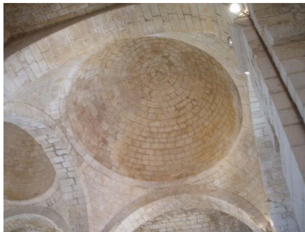
Figura 4. Ognissanti di Cuti. Particolare di una delle tre cupole in asse.
