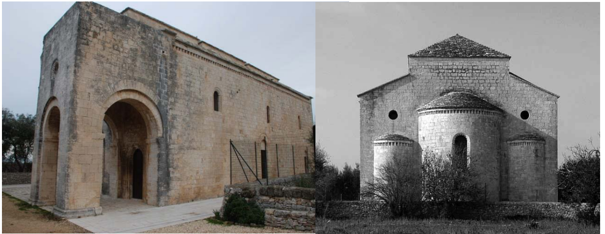
Figura 3. Valenzano. Ognissanti di Cuti, Edificio di culto, portico antistante e prospetto absidale.
