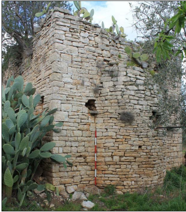
Figura 5. Bitonto, S. Croce, particolare dell'abside dell'edificio di culto.
