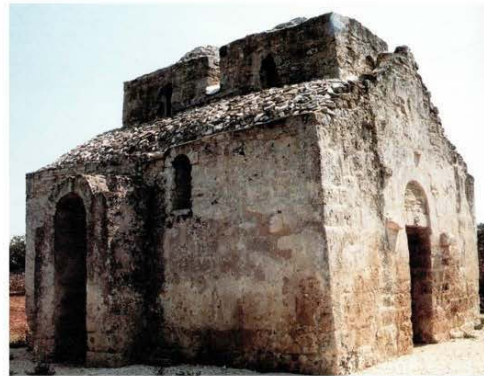
Fig.2. Fasano, tempietto di Seppannibale.
