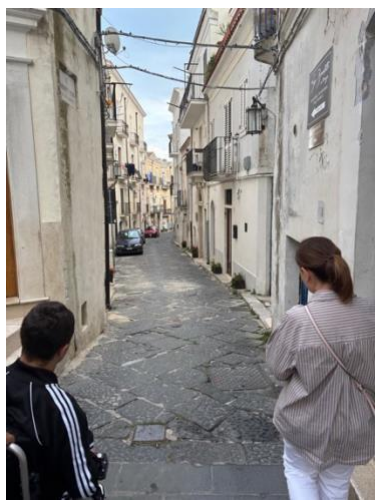
Figura 40 Pavimentazione irregolare lungo via Giuseppe Verdi
